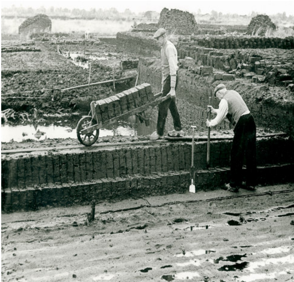
Turfstekers aan het werk met het typische gereedschap
